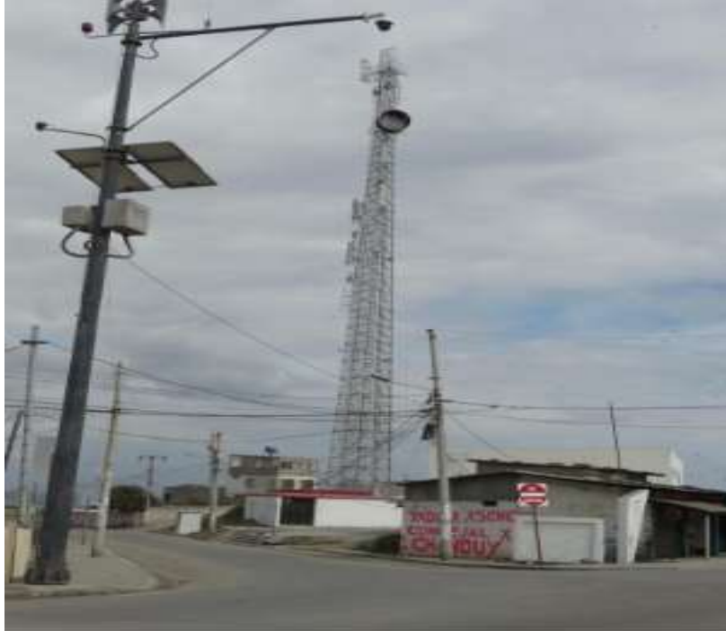
Ilustración 71: Vista de antena de conexión telefónica Fundación Gestión & Desarrollo, 2020
