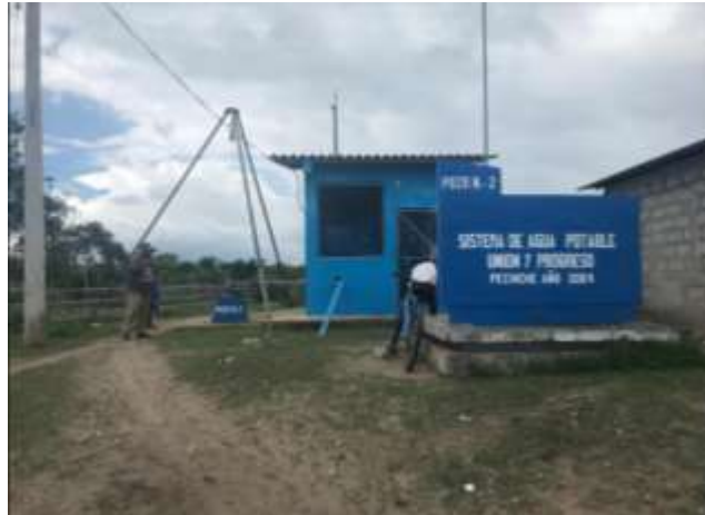
Ilustración 62: Vista de la estación de bombeo de Pechiche Fundación Gestión & Desarrollo, 2020
