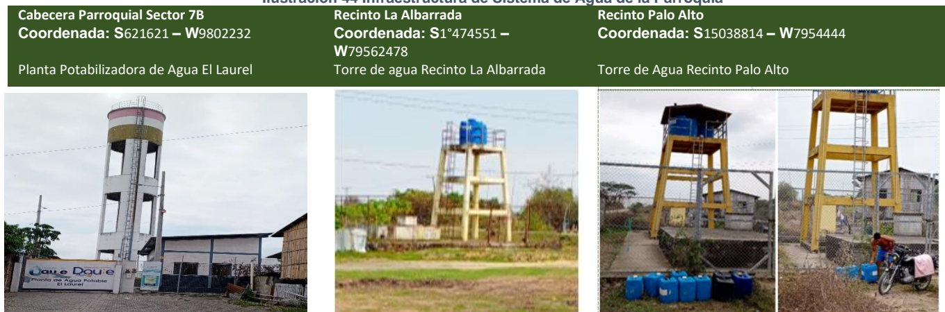
Ilustración 44 Infraestructura de Sistema de Agua de la Parroquia
