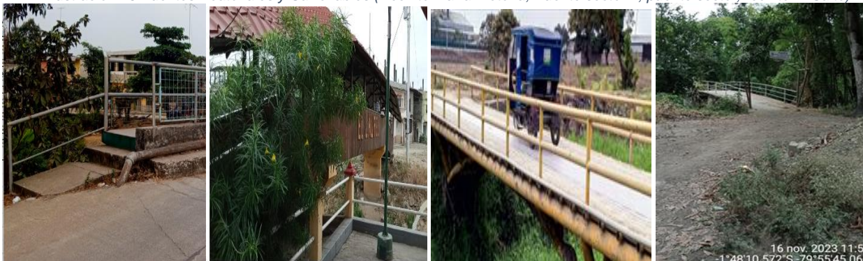
Ilustración 26 Puentes Peatonales y Carrozables (Recinto María Victoria, Puente sector 1, puente sector, recinto El Salto)
