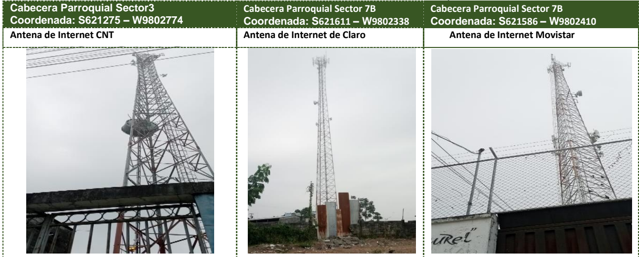
Ilustración 29. Antena de Telecomunicaciones ubicados en la Parroquia El Laurel
