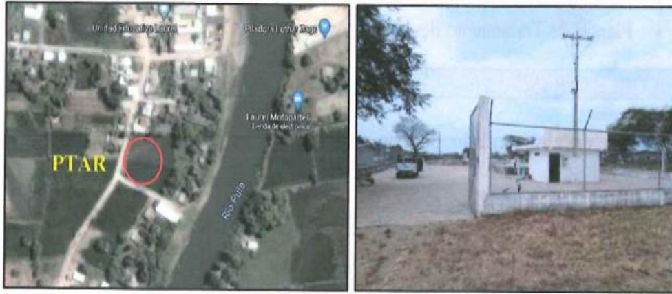
Ilustración 46 Planta de Tratamiento de Aguas Residuales Parroquia El Laurel
