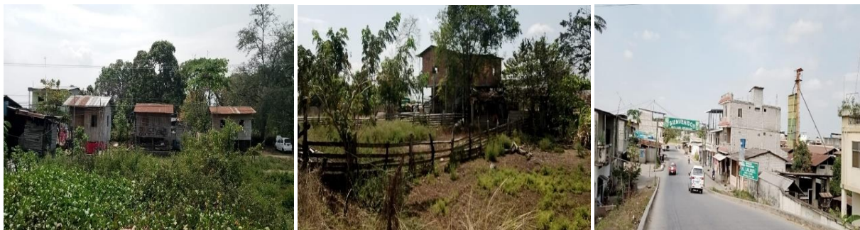
Ilustración 48. Viviendas de la zona rural y urbana de la parroquia El Laurel
