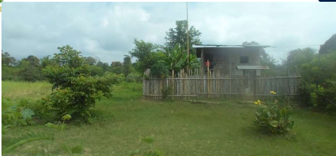
Fotografía 22.- Vivienda en situación de riesgo propensa a inundación.
