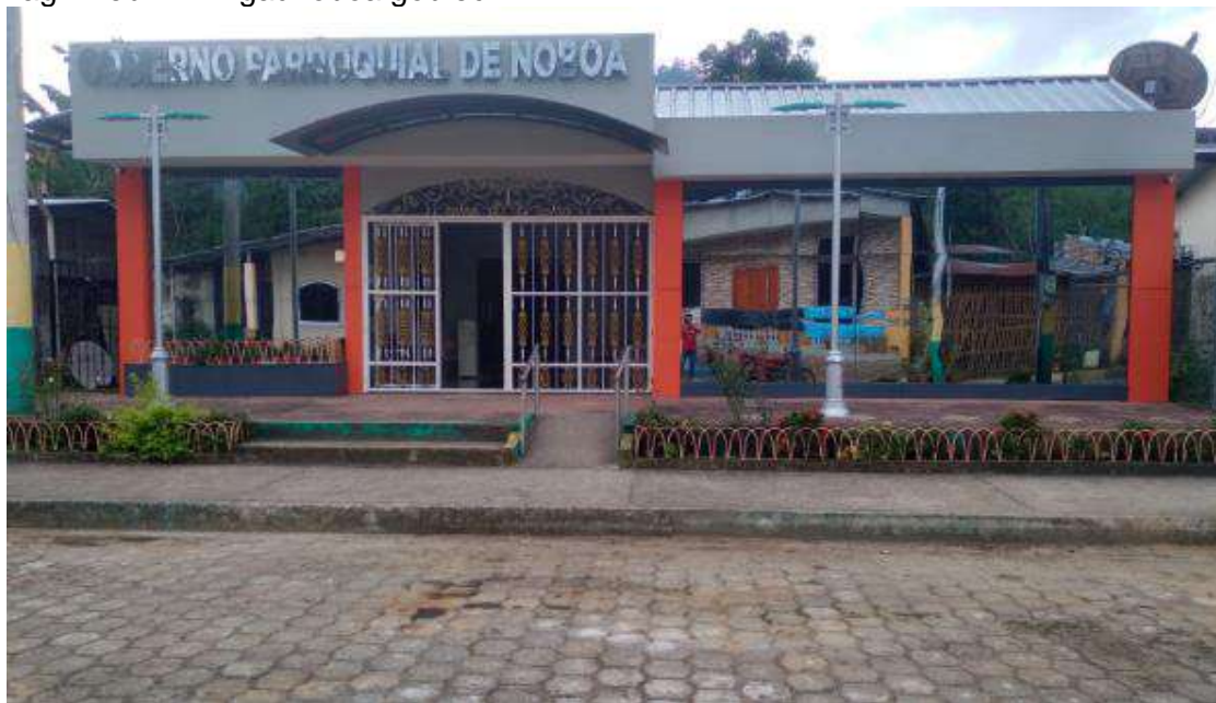
Ilustración N° 30 Edificio del GAD Parroquia Noboa Elaboración: Equipo Consultor PDOT 2023 -2027
