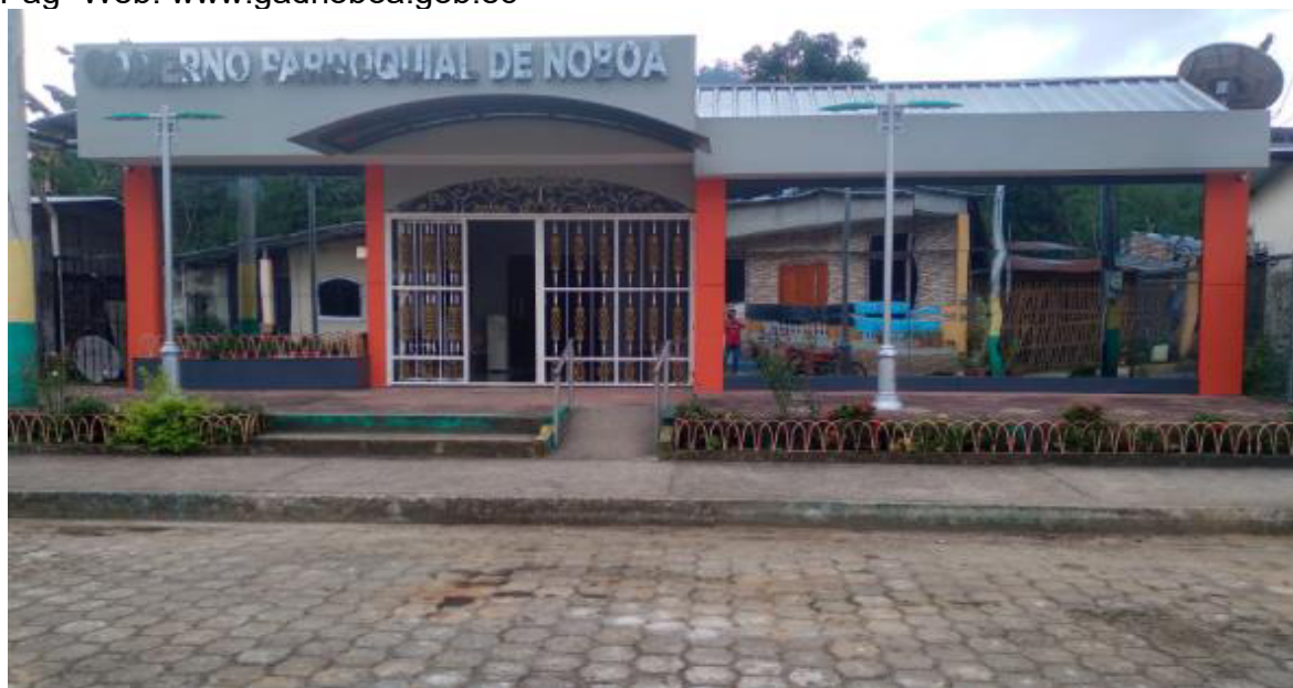
Ilustración N° 30 Edificio del GAD Parroquia Noboa Elaboración: Equipo Consultor PDOT 2023 -2027
