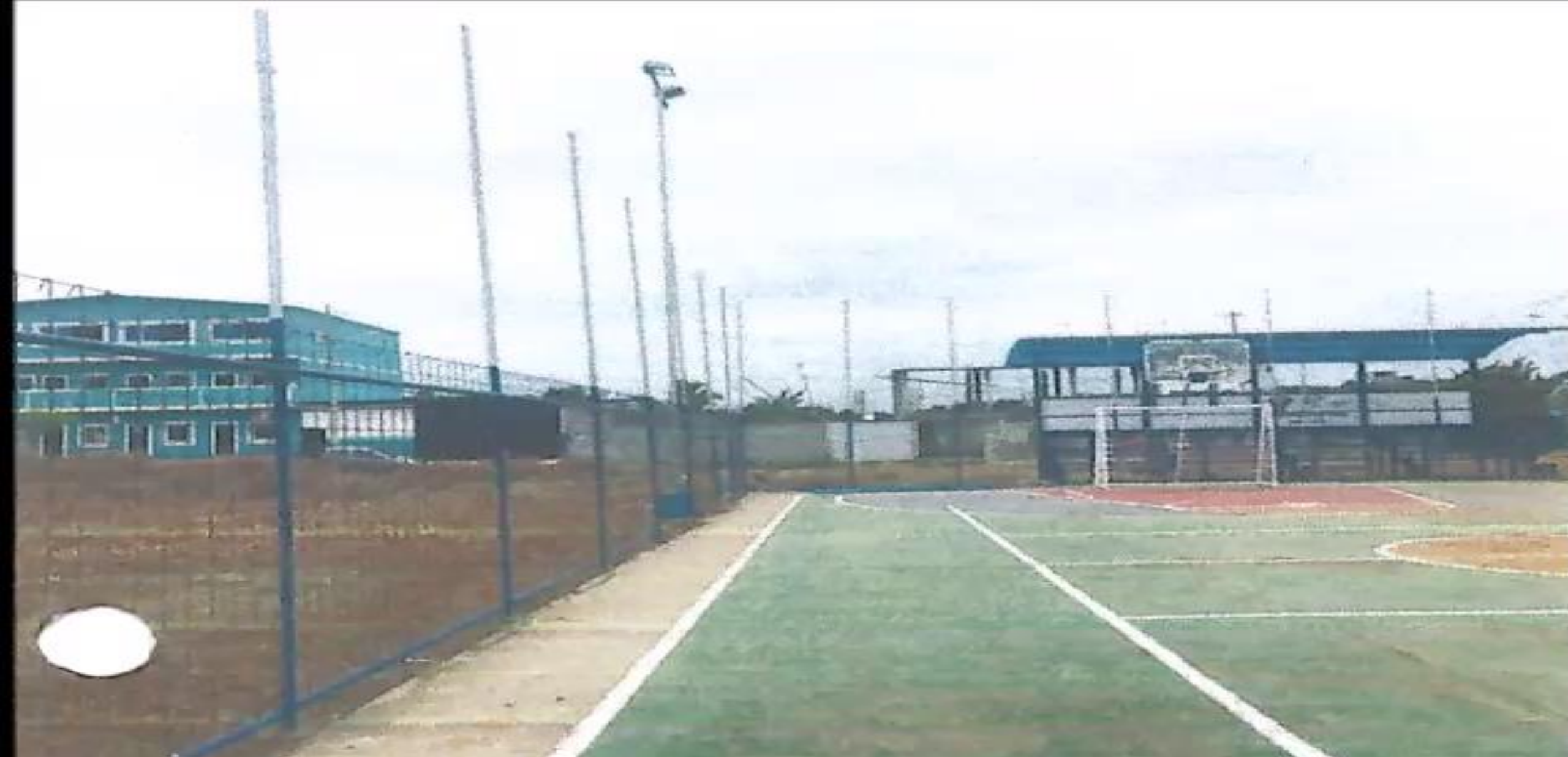
POA 2020: Instalación de mallas de nilón en cancha de Barrio Ciudad de Quito (1er. Trimestre)
