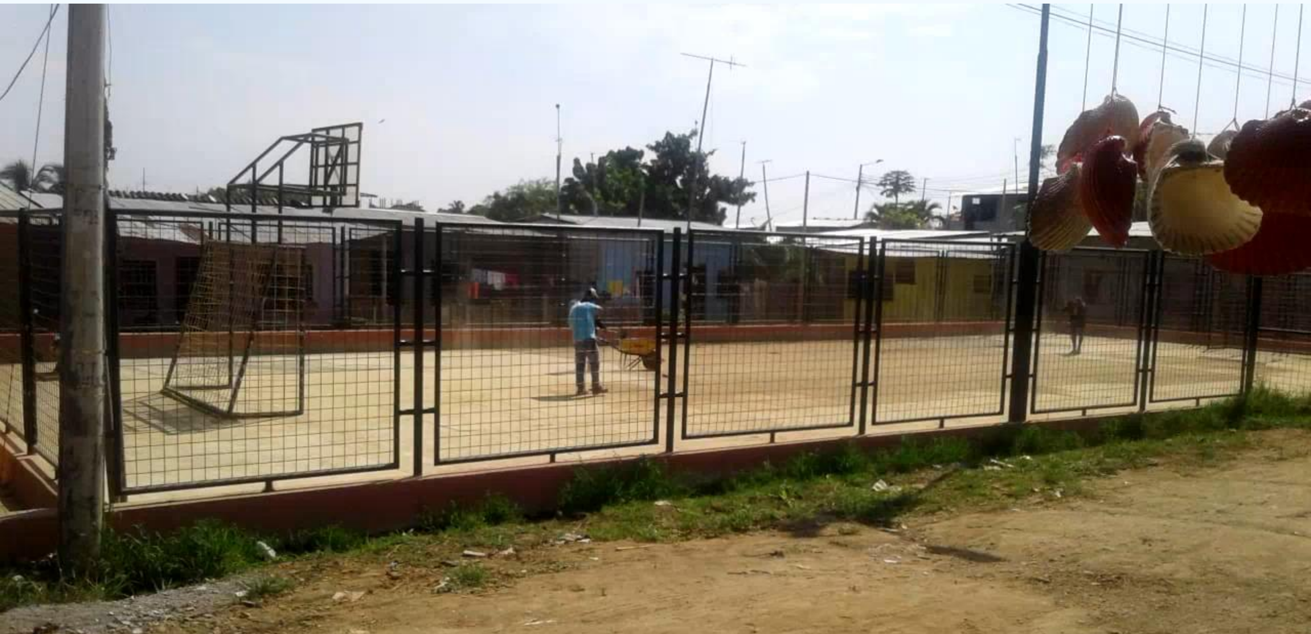
POA 2020: Mantenimiento y adecuación de la cancha del Barrio Colinas de Posorja (1er – 2do. Trimestre)
