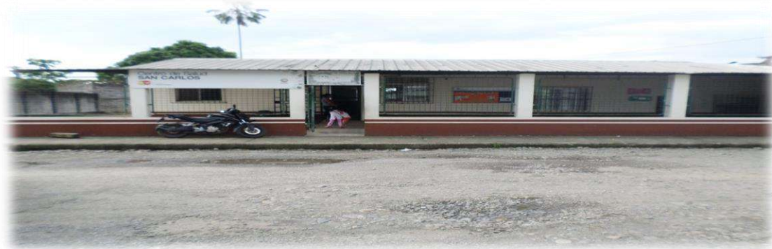
Foto 14: Subcentro de la Parroquia San Carlos.
